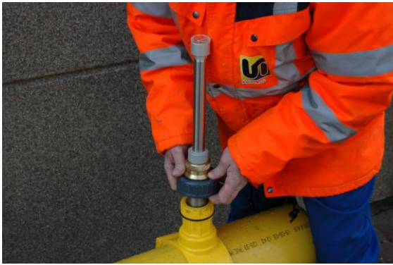
Jelölje meg az áramlásirányt egy filctollal majd távolítsa el a gáz áramlásirány mérőt.
