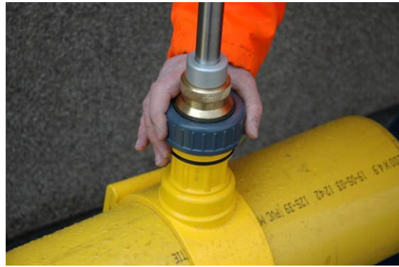
Helyezze az áramlásirány mérőt a sárga POLSAFE megfúró idomra és rögzítse a mérőt a persely teljes mértékben történő lecsavarásával.
