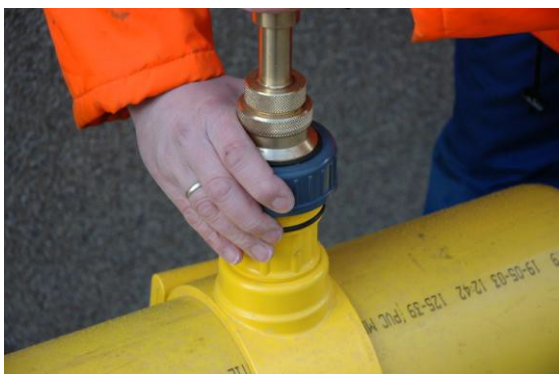
Rögzítse az adaptert a Polsafe megfűró idomban.
