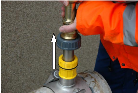
Távolítsa el az egész nyomás alatti megfúró szerszámot a sárga POLSAFE megfúró idomról. TIPP: a szerszám szétszerelésénél ajánlott a perselyt ismét visszahelyezni a megfelelő pozícióba (3-4 mm) a következő nyomás alatti megfúráshoz.
