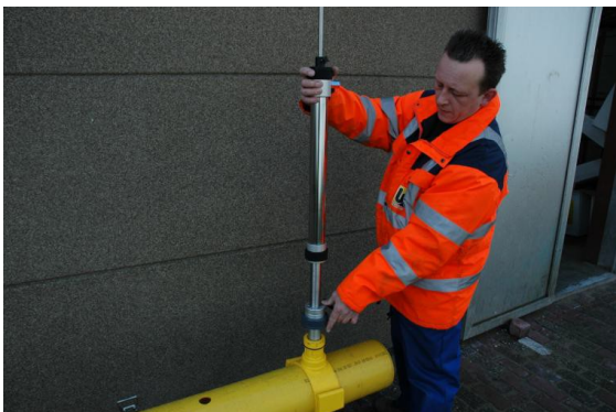
Helyezze a dómot a sárga megfúró idomra. Bizonyosodjon meg arról, hogy a nyomáscsökkentő szelep az áramlás irányába mutat. Jól feszítse meg a szürke perselyt.
