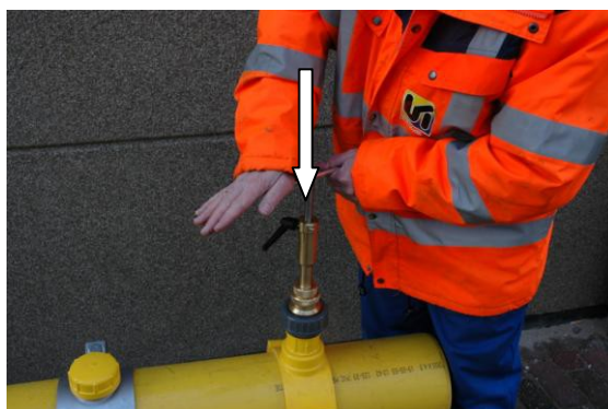
Nyomja lefelé az orsót, amíg a maró vagy fúró megérinti a cső falát.
