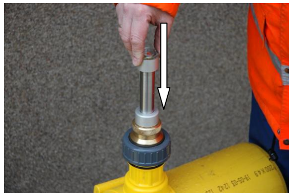
Tolja le teljesen az áramlásirány mérőt.
